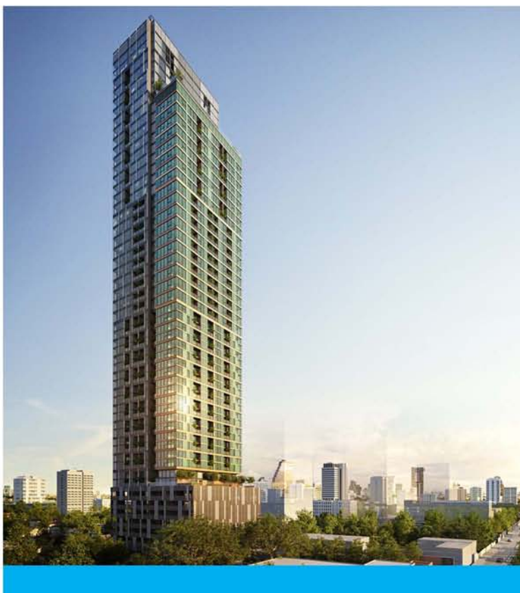
โครงการ THE LOFTS SILOM-MAIN TOWER
